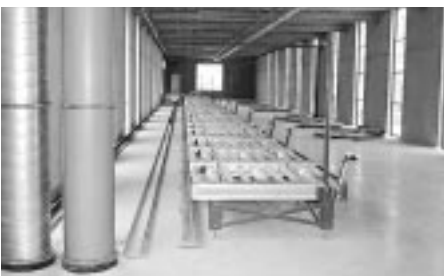
Bild 5: Die Produktionshalle im Aufbau
