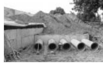
Bild 8: Der Erdkanal in Bau
